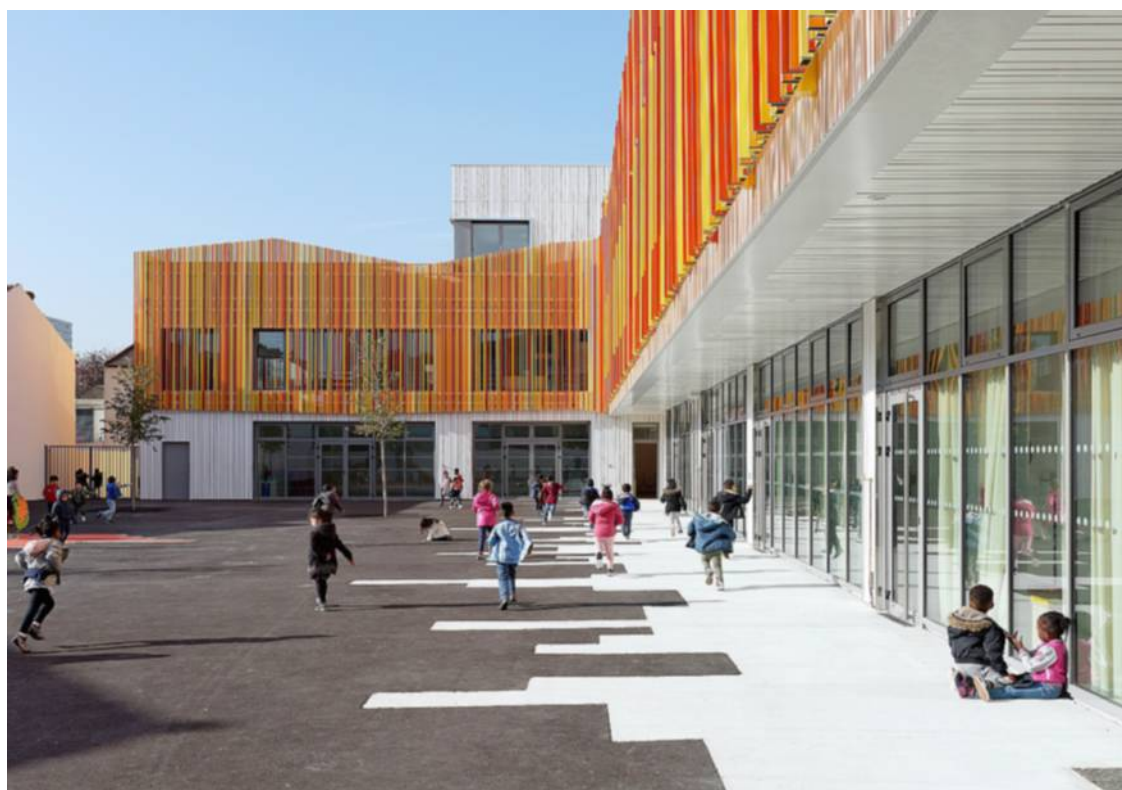
L'école Makarenko à Ivry-sur-Seine, dans le Val-de-Marne. David Boureau
